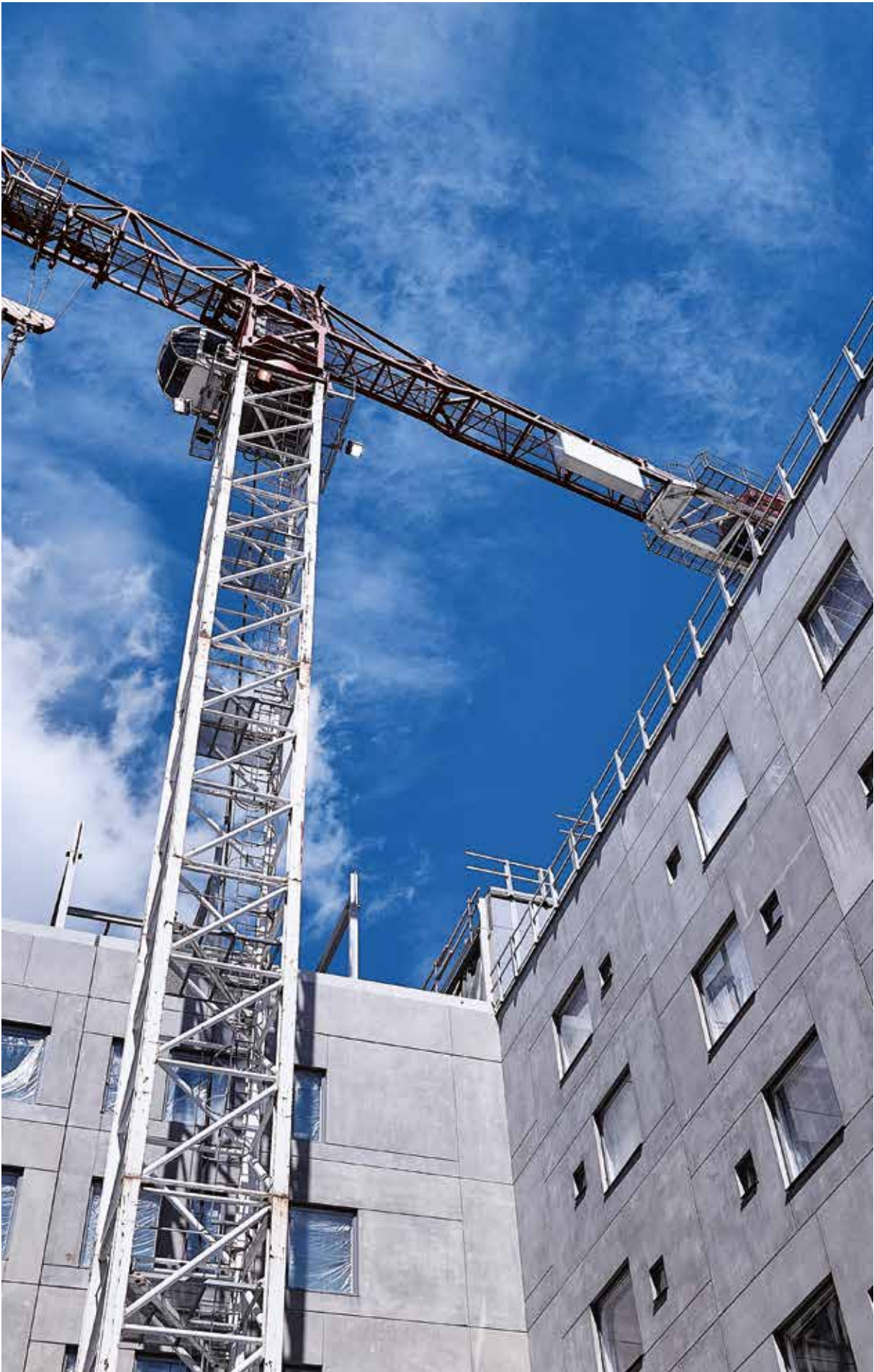
Kuva: Lujitalo Oy
